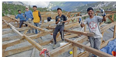
Reparatur in Nepal: Schmitt und vier junge Nepalesen dichten das Dach der Schule ab.
