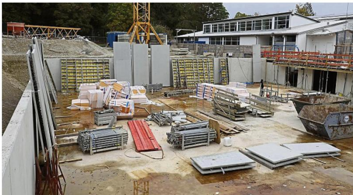
Hier entsteht die neue Schulturnhalle in Icking. Nach anfänglichen Verzögerungen läuft nun alles nach Plan.
