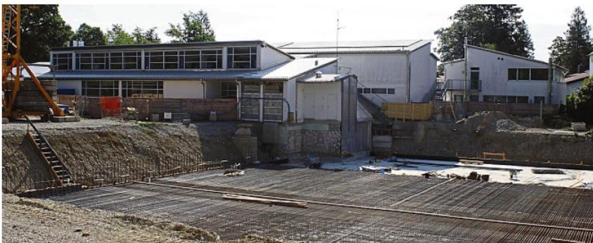
Stockende Bauarbeiten: Die neue Turnhalle an der Grundschule wird voraussichtlich erst in einem Jahr eröffnet.
