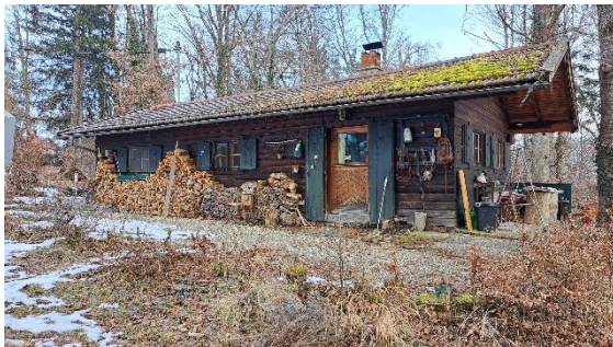
Abbildung 4: Zum Abriss vorgesehenes Gebäude
