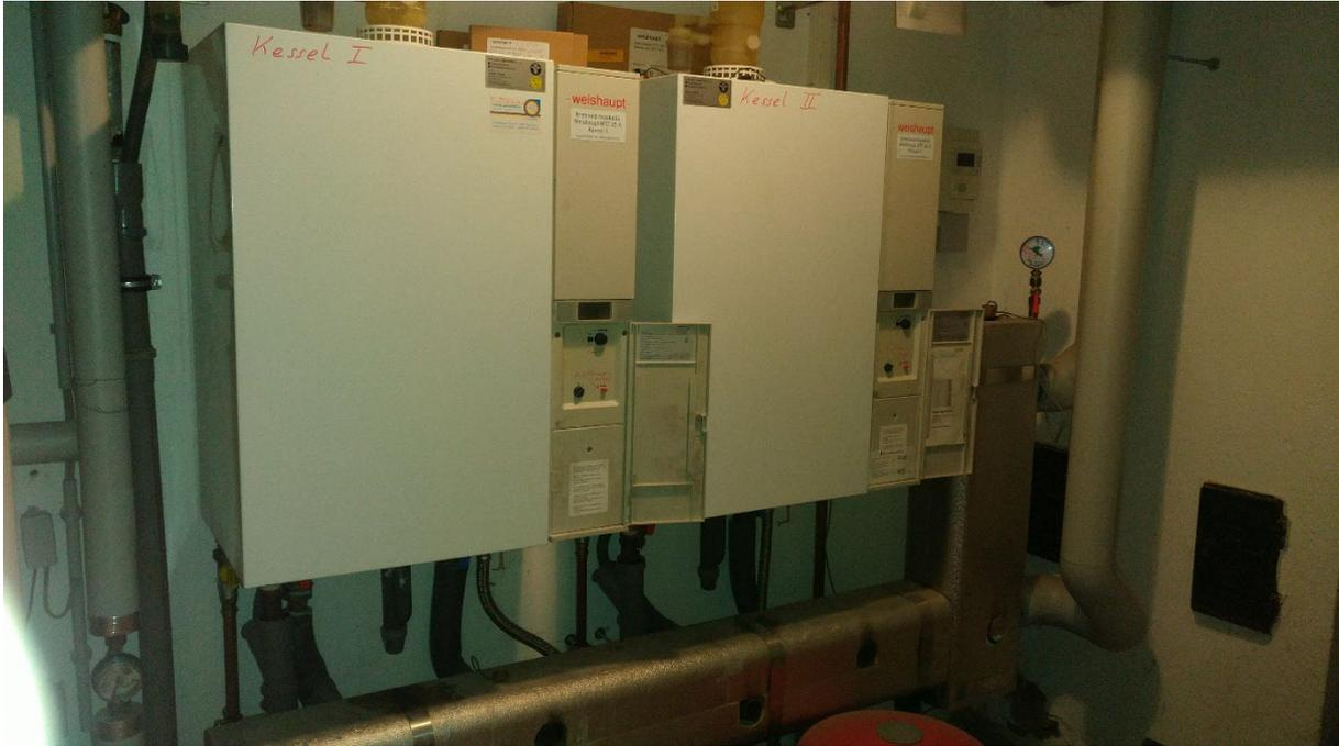
Abbildung 9-4: Brennwert-Kaskadenanlage FFW Icking.
