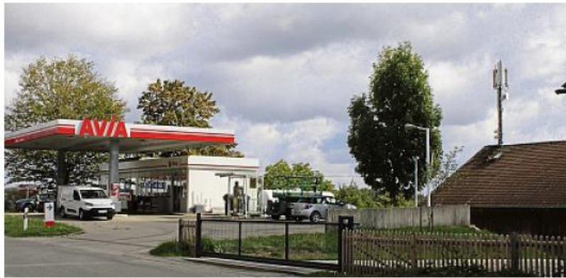
Ein großer Mast soll kleine Mobilfunkantennen wie hier neben der Tankstelle an der B11 ersetzen. PETER HERRMANN
