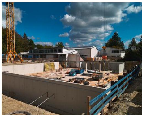
Die neue Zweifachturnhalle in Icking nimmt Gestalt an: Fundament und Kellerwände sind bereits fertiggestellt. Der Rohbau läuft nach den Verzögerungen inzwischen nach Zeitplan.
